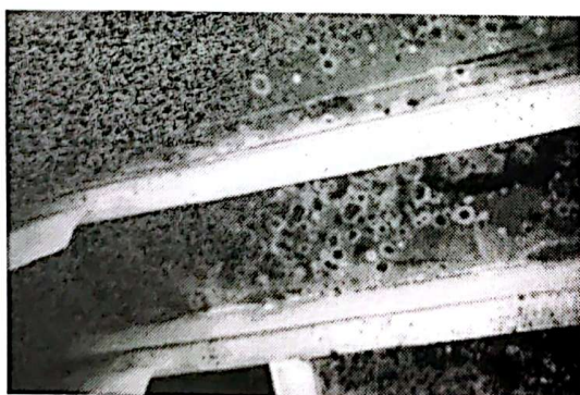
รูปที่ 3 - 2 การเสื่อมสภาพของฟิล์มสี
