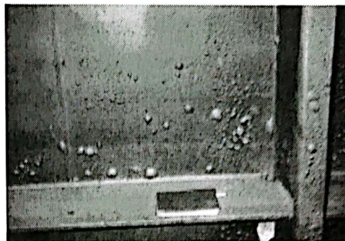
รูปที่ 3 - 3 การเสื่อมสภาพจากตม่น้ำหรือตม่นองของฟิล์มสี
