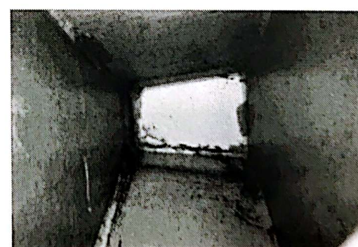
รูปที่ 3 - 5 การเสื่อมสภาพจากการแตกร้าบริเวณแนวเชื่อม
