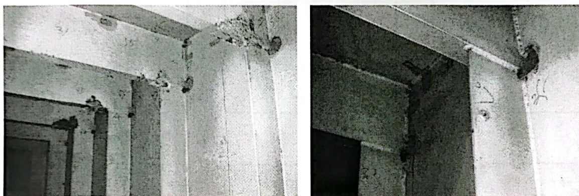
รูปที่ 3 - 10 การเสื่อมสภาพจากการกักตรอนบริเวณที่มีความเค้นหรือความเครียดสูง
