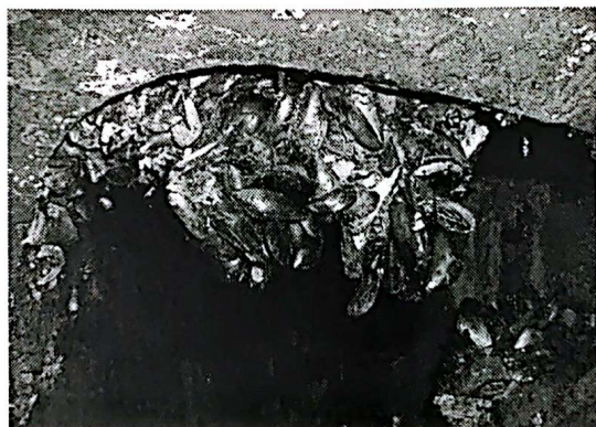
รูปที่ 3 - 17 การอุดตันในช่องทางระบาย
